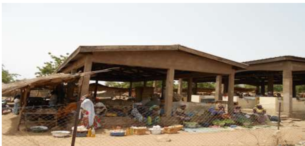
PHOTO : Les infrastructures marchandes (hangars)
