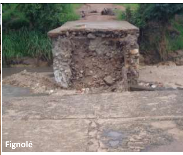
Mauvais état des routes et ponts dans l'Arrondissement de Poli (Pintchoumba; Figolé, Ouro Baï, Delta1) provoqué par les pluies abondantes et torrentielles Mai 2013
