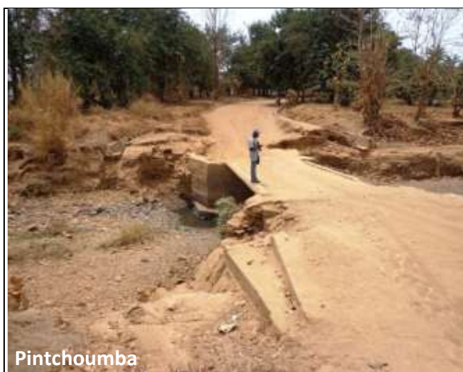
Mauvais état des routes et ponts dans l'Arrondissement de Poli (Pintchoumba; Figolé, Ouro Baï, Delta1) provoqué par les pluies abondantes et torrentielles Mai 2013
