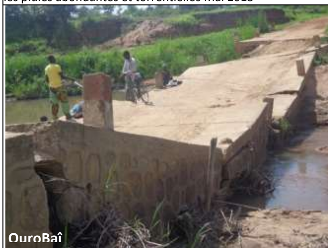
Mauvais état des routes et ponts dans l'Arrondissement de Poli (Pintchoumba; Figolé, Ouro Baï, Delta1) provoqué par les pluies abondantes et torrentielles Mai 2013
