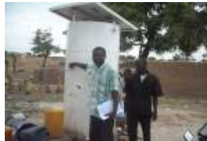
Photo 8: Forage à distribution automatique par énergie solaire à Madingring
