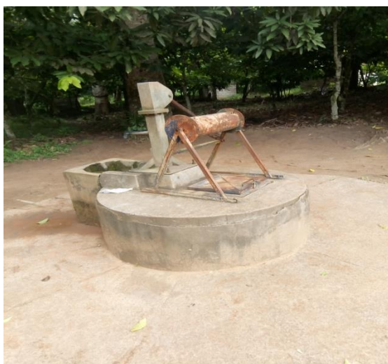
Photo 2 : Puits équipé de PMH au village de BOTATANGO
