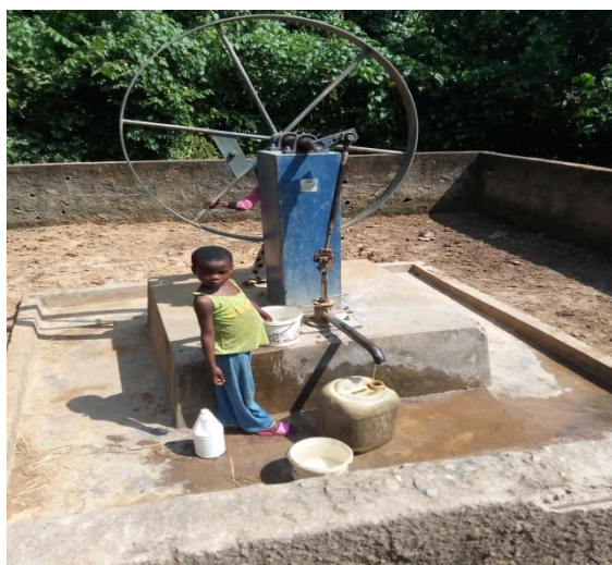
Photo 1: Forage (Volanta) à BOALONDO
