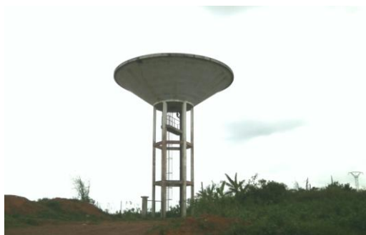
Photo 10: Le château d'eau du réseau CDE à Ngoumou
