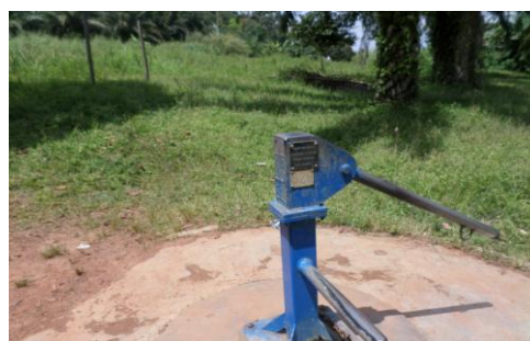
Photo 9: Un puits équipé d'une PMH à Nkongmeyos II
